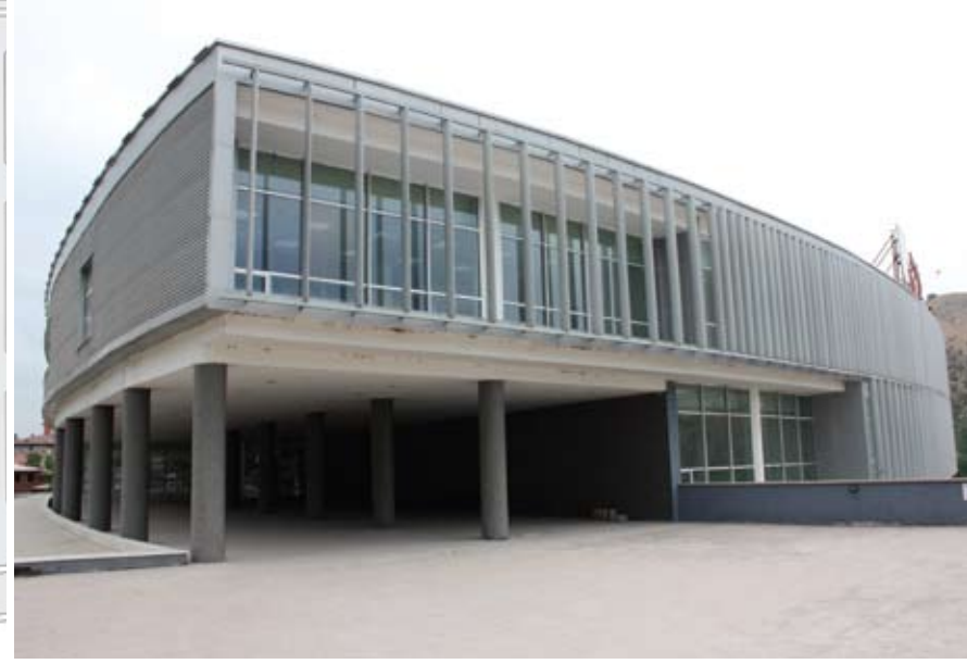
Üst kottan yaklaşım, batı cephesi.
