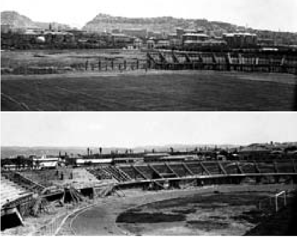
Ankara 19 Mayıs Stadyumu inşaatı
