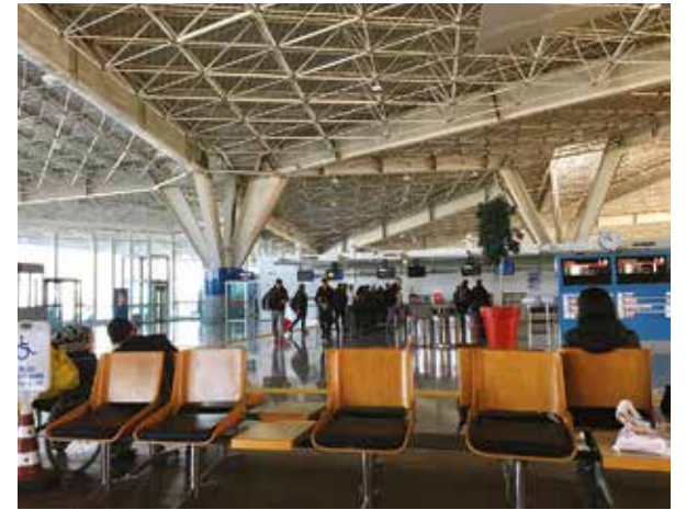
10- Kars, Haraani Havalimanı Terminal Binası
