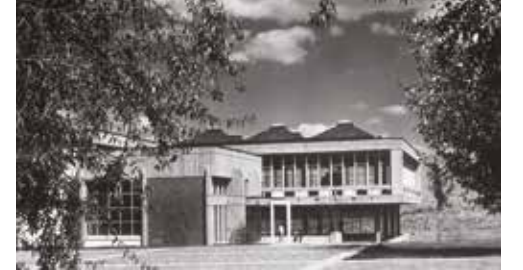
ODTÜ Kampus Binaları, Behruz Çinici
