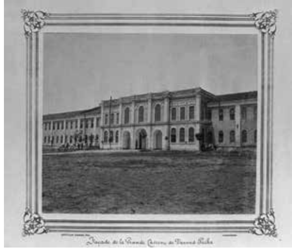
Resim 01: Davutpaşa Kışlasının Giriş Cephesi
