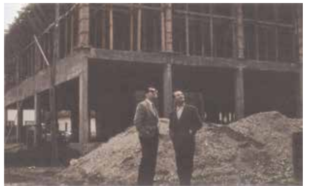
Sakarya Hükümet Konağı inşaatı Enis Kortan ve Nişan Yaubyay
