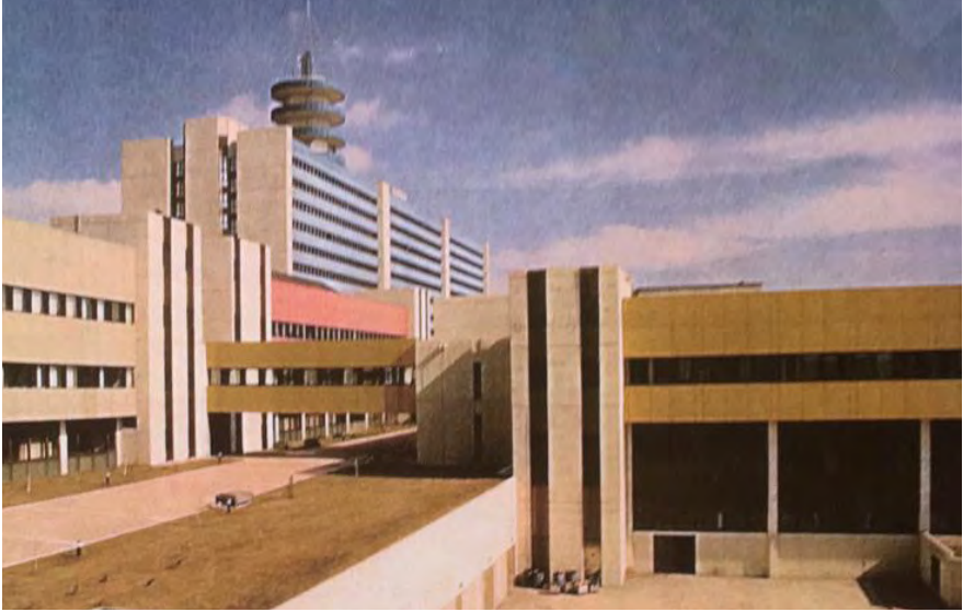
TRT Genel Müdürlüğü Tesisleri , YEG Mimarlık
