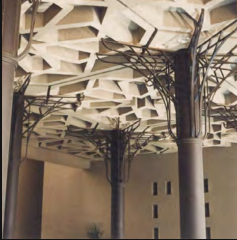
Riyad TC Büyükelçilik Binası ve iç kolonları
