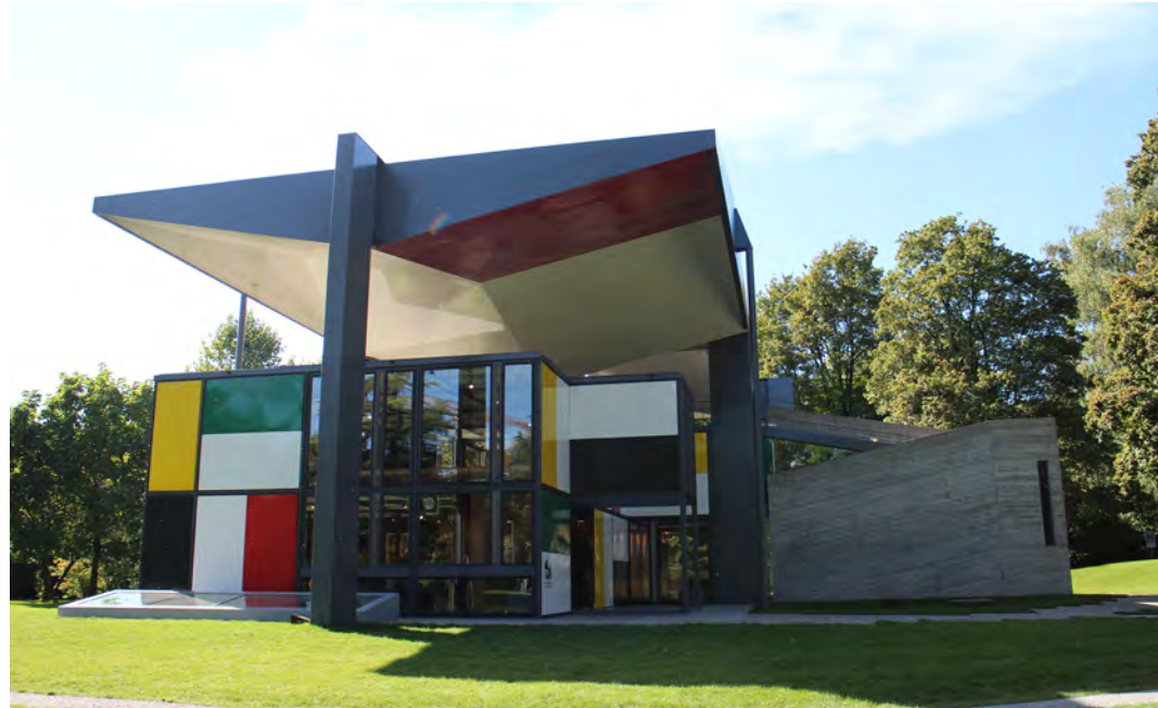
Resim 1: Le Corbusier Pavyonu Doğu Cephesi, A. Özmen
