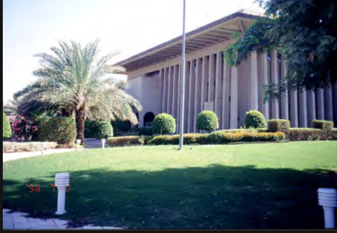
Riyad TC Büyükelçilik Binası
