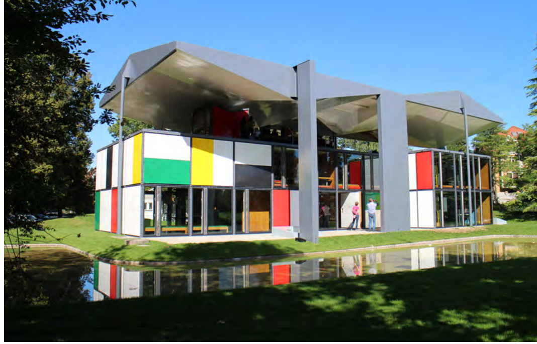
Resim 2: Le Corbusier Pavyonu Doğu Cephesi, A. Özmen
