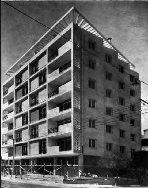
Fuat (Alber Kohen) Apartmanı, Alsancak-Konak, İzmir, 1965 "Bir Apartman İzmir", Arkitekt Dergisi 302, 01/1961, ss. 6-8
