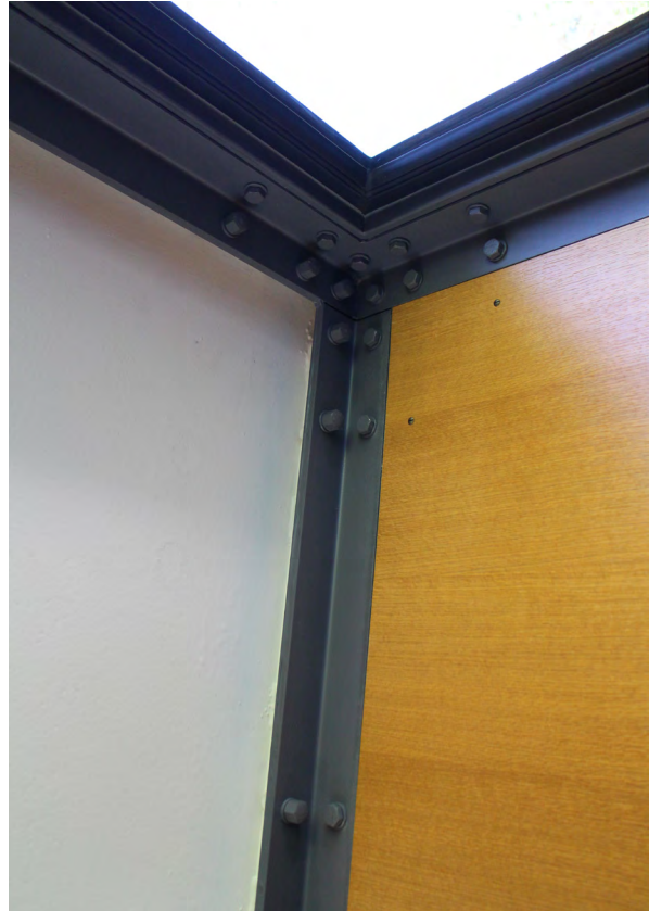
Resim 16: Duvar-tavan birleşim detayı, A. Özmen
