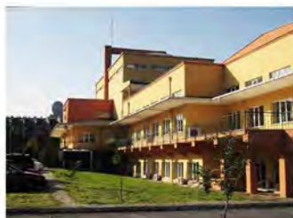
Genel Müdürlük Hizmet Binası, 2008 dejenerasyonları
