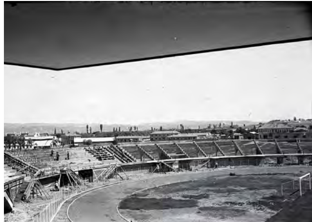
19 Mayıs Stadyumu inşaat halinde (Salt Araştırma, Fotoğraflar, TASUH8280001)
