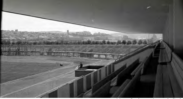
19 Mayıs Stadyumu inşaat halinde (Salt Araştırma, Fotoğraflar, TASUH8280002)
