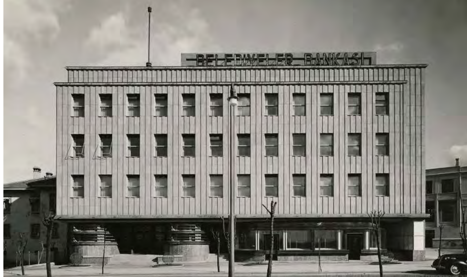
Batı Cephesi, Tadilat (1947) öncesi
