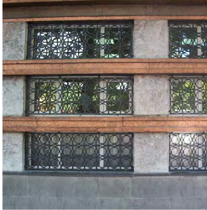
Yenileme öncesi, Ön cephe Detay
