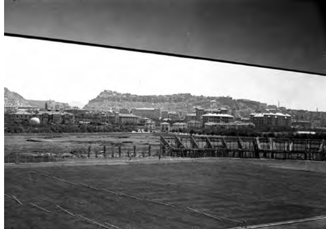
19 Mayıs Stadyumu inşaat halinde (Salt Araştırma, Fotoğraflar, TASUH8280004)
