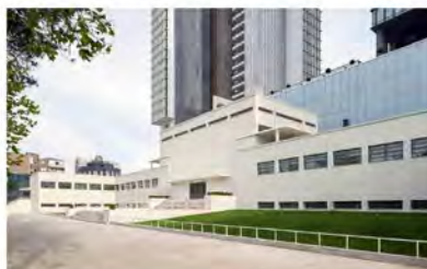
Pilevneli Gallery, 2018 EAA'nın uyarlanabilir yeniden işlevlendirme projesinden sonra
