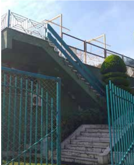
Şekil 10. Giriş merdiveni ve korkuluklar (Fotoğraf: Ayşenur Meşe, 2022)
