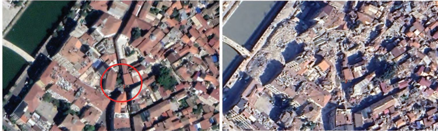
01.2021 Hava fotoğrafı , Antakya
