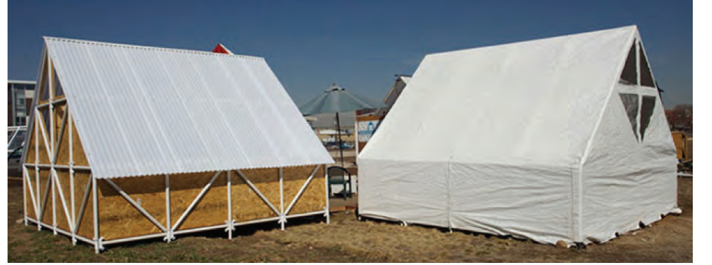
Resim 3. Dönüştürülebilir HHI afet sonrası barınma birimi, ES ve LTD (https://www.uoalumni.com/s/1540/21/interior.aspx?sid=1540&gid=3&pgid=3223).
