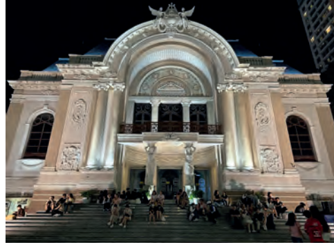
Resim 3. Saygon Opera Binası.
