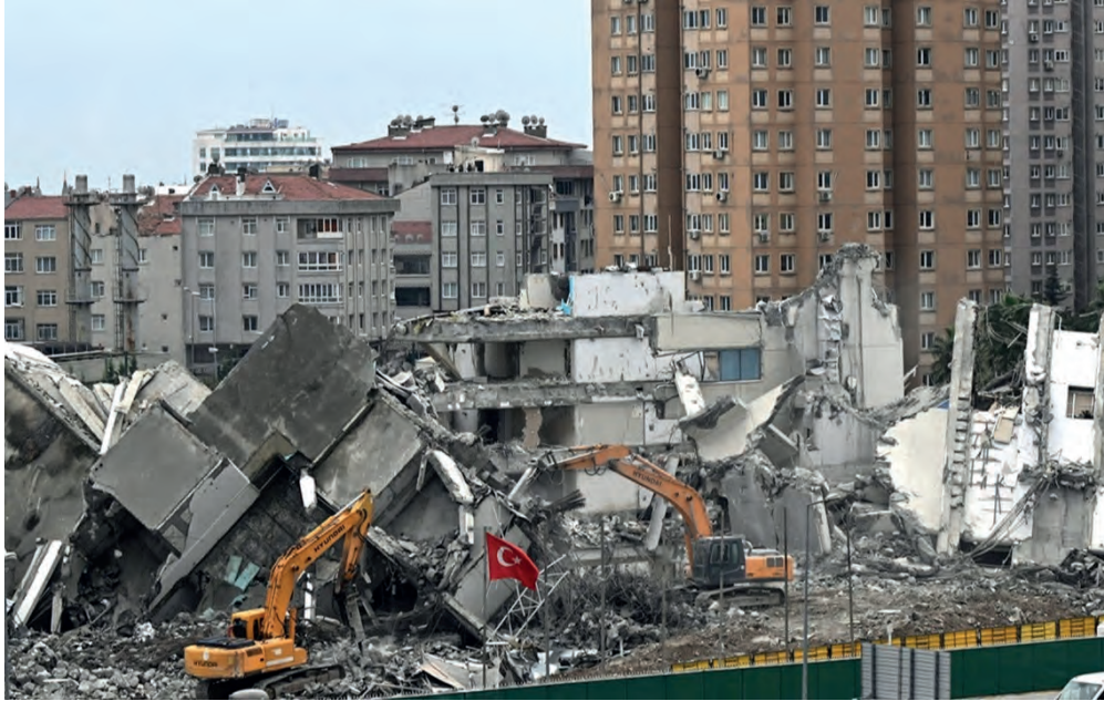
Resim 2. Tercüman Binası yıkımı sırasında (AA).
