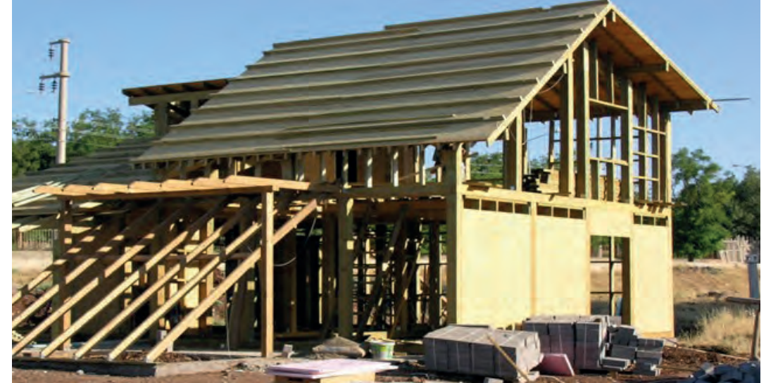
Resim 13. Diyarbakır Güneş Evi ahşap strüktür.
