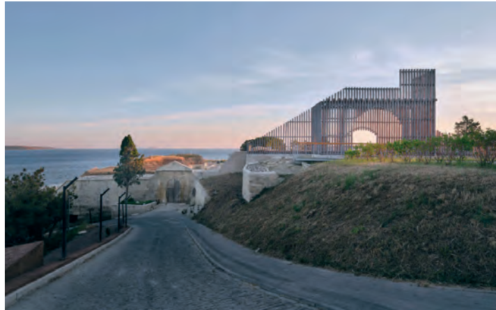
Yapı Koruma Dalı Ödülü, Seddülbahir Kalesi.
