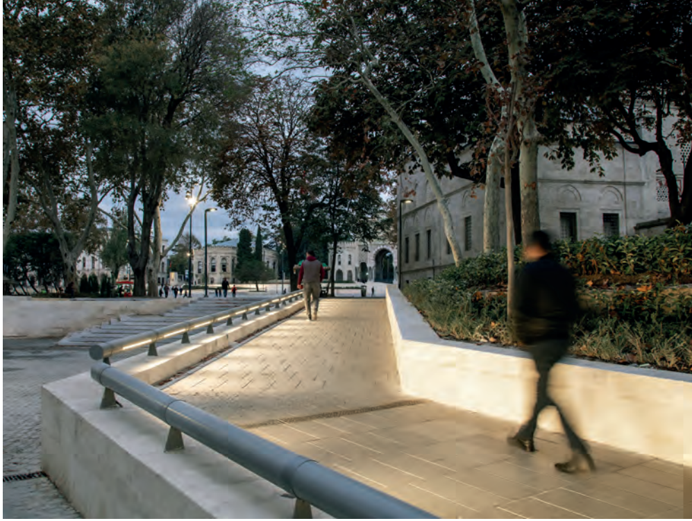
Resim 10. Kapalıçarşı Meydanı'ndan Meydan'a çıkan engelli erişim rampası ve aydınlatması.
