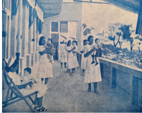
Resim 13. Umay Pavyonu balkonundan bir görünüm (25 Yıl).
