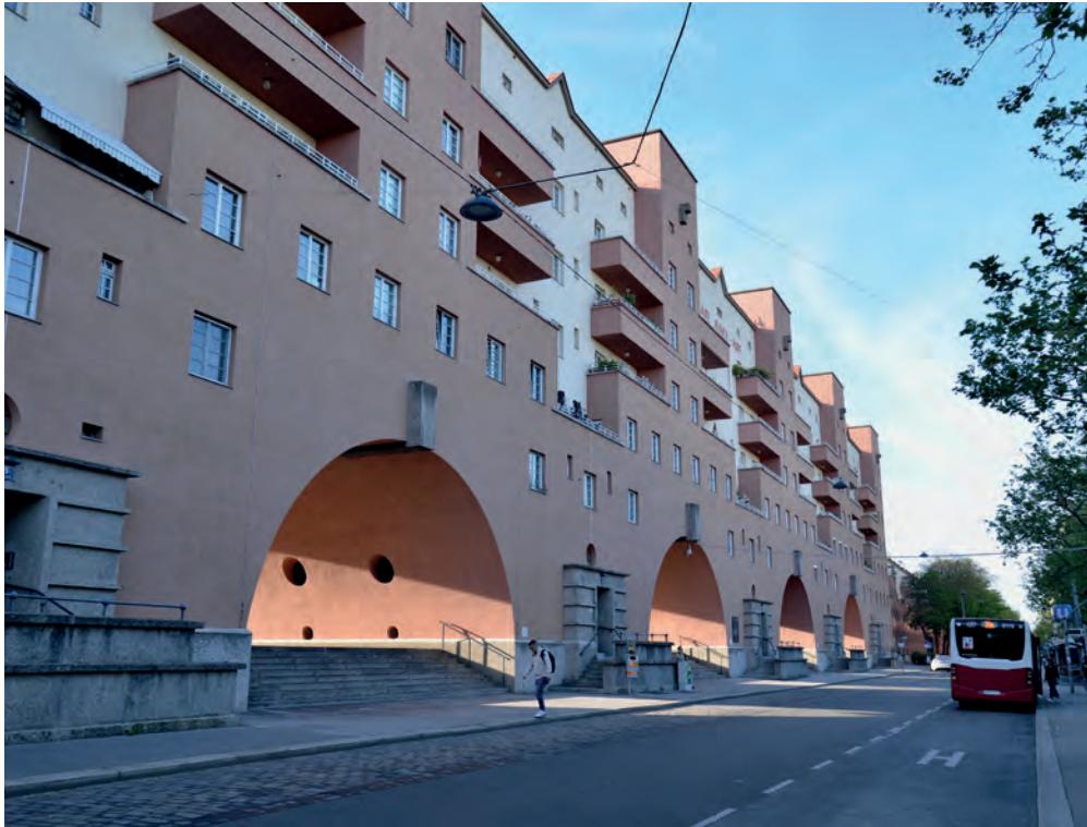
Resim 12. Karl Marx Hof, sokak görünüşü.
