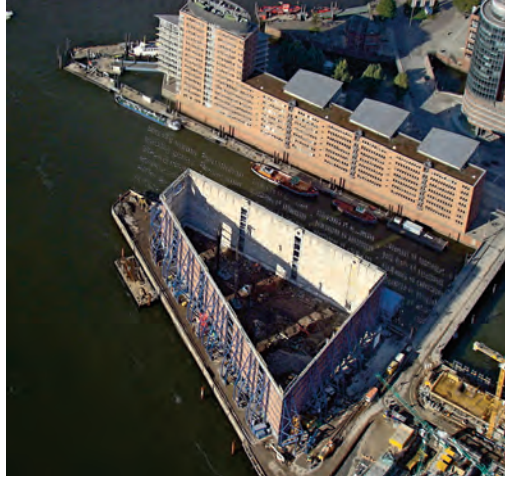
Resim 26. Eski yapının cephesinin korunması.
