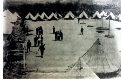
Resim 5. Gölköy'de inşaat çalışmaları başlamadan önce çadırların kurulu olduğu meydan ve çadırlar (Bizim Ordugâh Balkır'ın arşivi) (Balkır, 2002).
