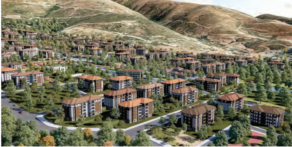
Özgüven Mimarlık bürosu tarafından projelendirilen Hatay, Gülderen deprem konutları.
