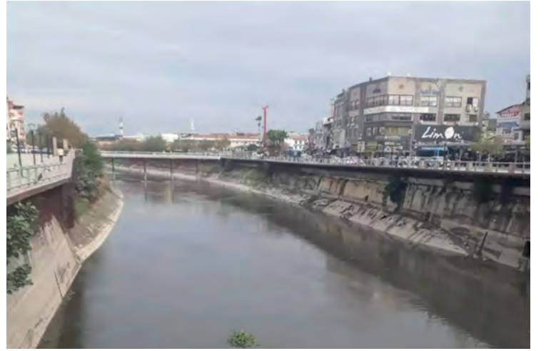
Asi'nin beton kanal içine alınarak çukurlaştırılmış bugünkü hali.
