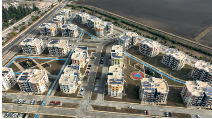
TOKİ tarafından yapılan Adana, Ceyhan'daki deprem konutları.
