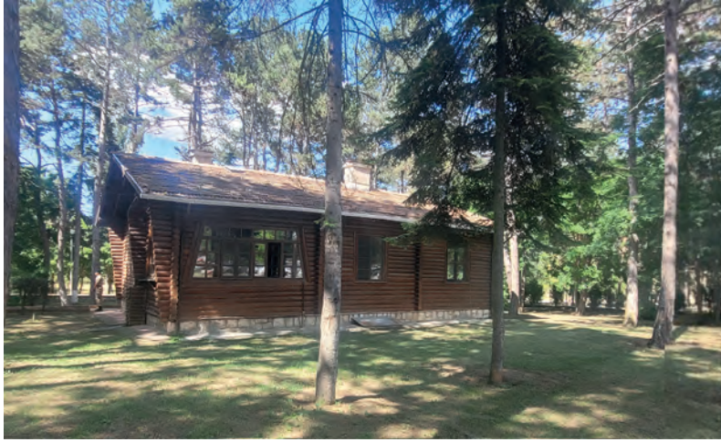
Resim 19, 20. Eski Müdür Lojmanı olan 17 no.'lu yapıya ait fotoğraflar.
